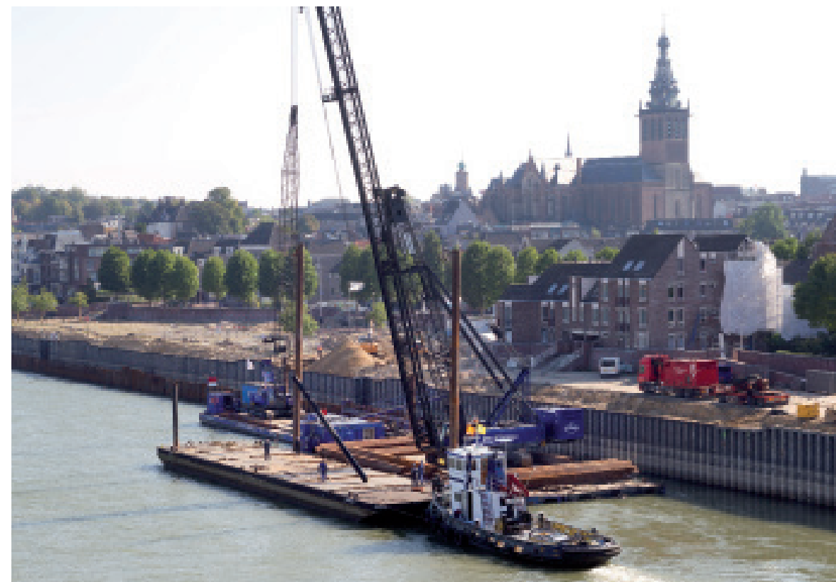
Vervanging damwand westelijke Waalkade, Nijmegen.
