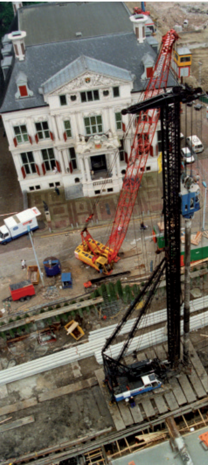
Nabij het karakteristieke Schieland-huis, trillingsvrij inbrengen van prefab betonpalen voor Cr dit Llyonnais, 1996.
