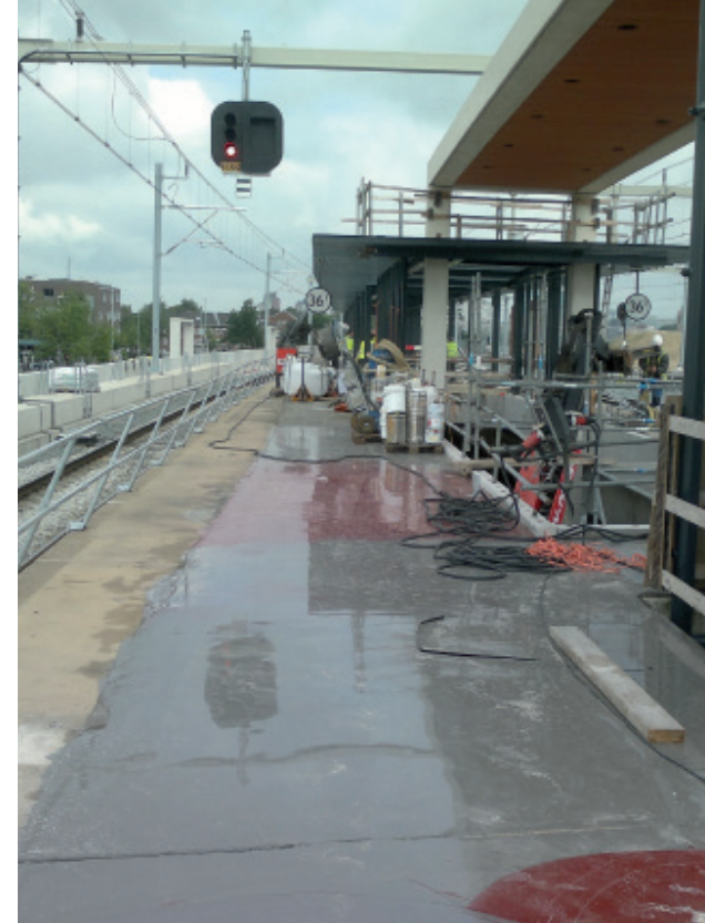
Project VleuGel, Utrecht. Aanbrengen epoxy afwerking op perron, 2013.
